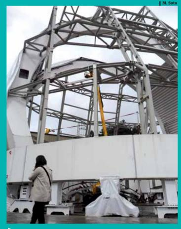
Tecnología vasca para el mayor telescopio solar. Bajo la dirección de la ingeniería Idom, Talleres Gometegui e Hilfa están construyendo en Bizkaia el domo del proyecto ATST, el mayor telescopio solar que se levantará en Hawai. El domo es la estructura que envuelve y protege el telescopio, y el movimiento de su ventana de observación ha sido desarrollado por Idom. Este proyecto es un ejemplo de la capacidad de la industria vasca para acometer grandes proyectos internacionales. [P 7
